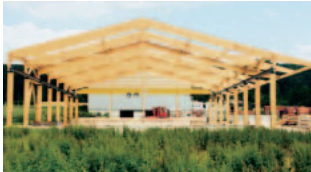
Kerto-Systemhalle mit Kranbahn und Satteldach in Lienen
