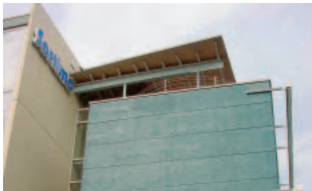
Kerto-Fassade „Sortimo“ in Zusmarshausen
