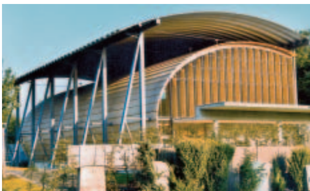
Aussegnungshalle aus imprägniertem Kerto in Gräfelfing
